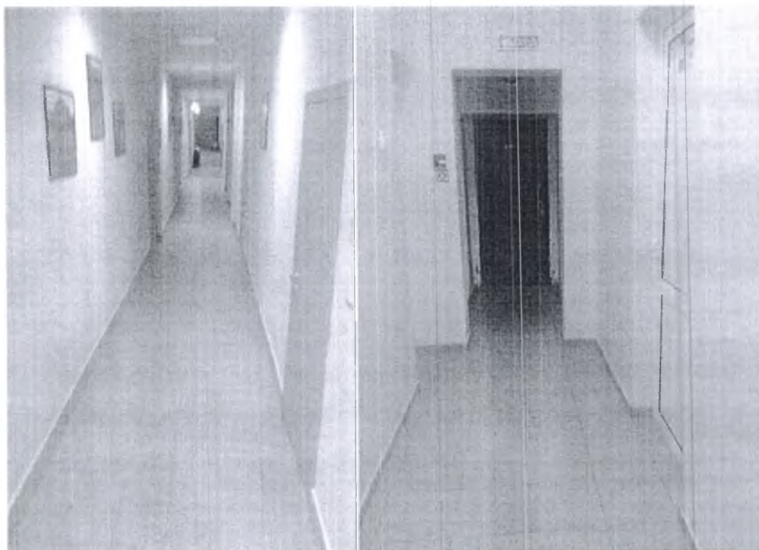
Фото №9. Пути эвакуации.
