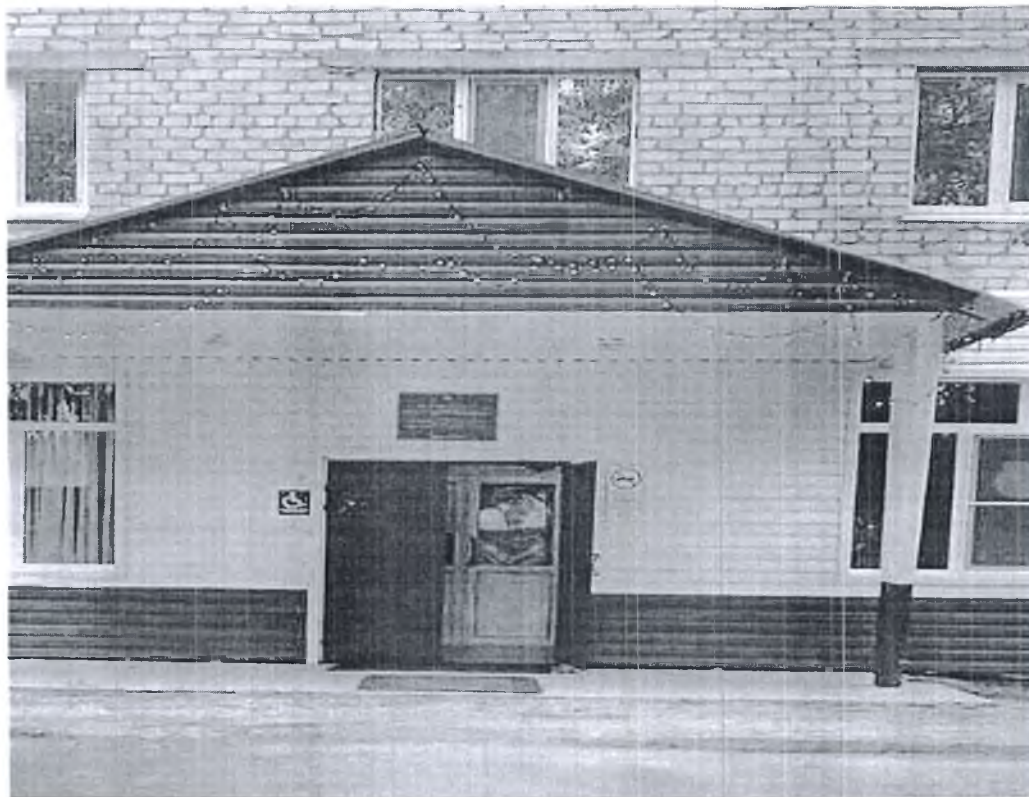
Фото №4. Вход в здание
