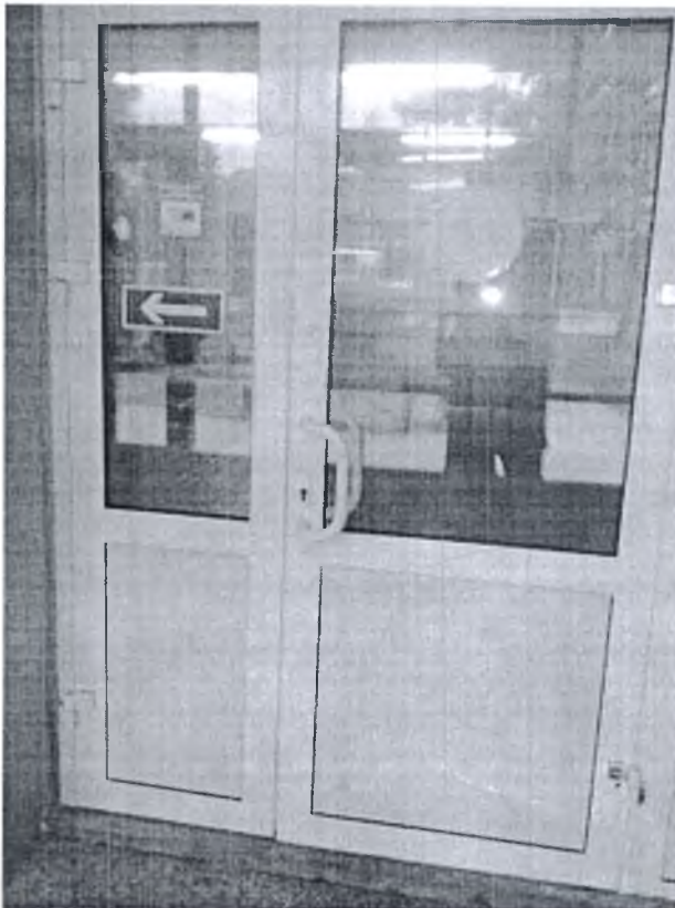
Фото №2 Дверь входная.
