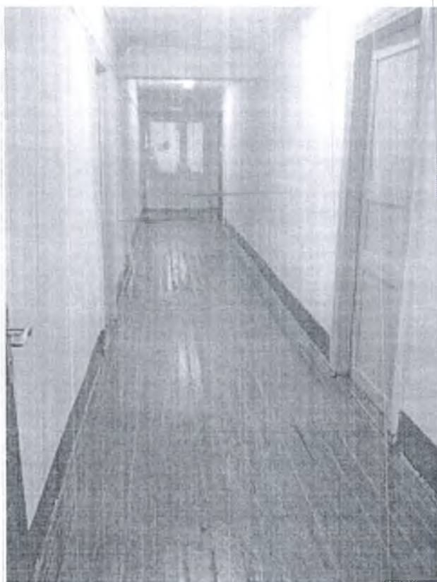
Фото №9. Пути эвакуации. Пути движения внутри.
