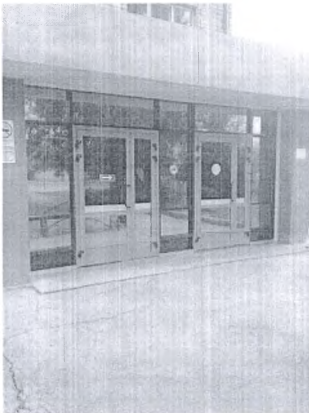
Фото №2 Дверь входная.
