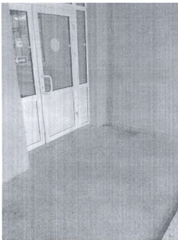
Фото №3. Тамбур. Входная площадка.
