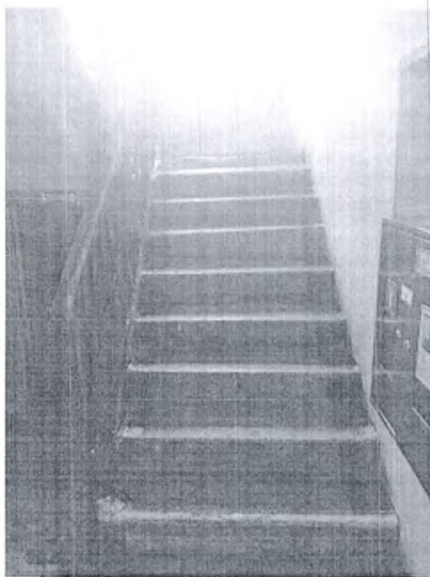
Фото№7. Лестница внутри.
