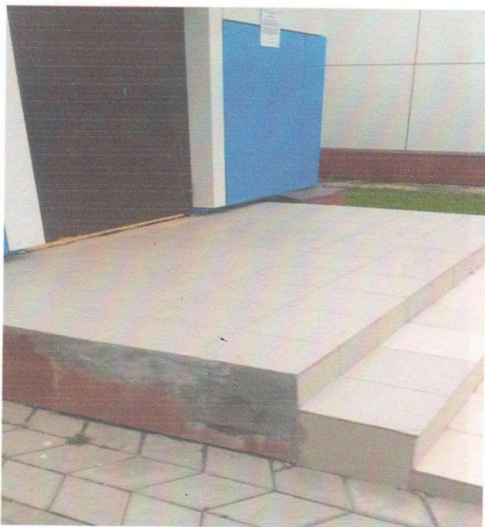
Фото №3. Входная площадка.
