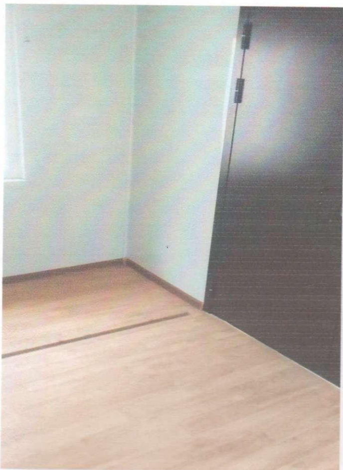
Фото №4. Тамбур. Вход в здание
