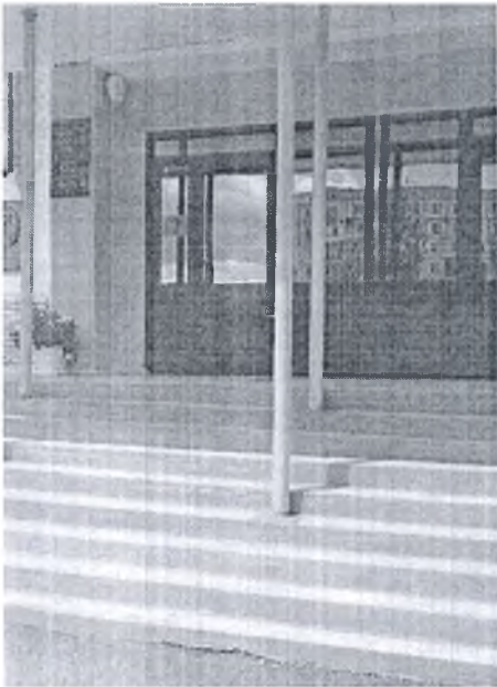
Фото №5 - Лестница наружная
