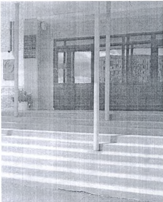
Фото №3 - Лестница наружная
