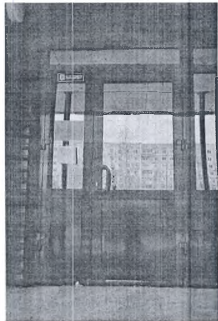
Фото №8 - Дверь входная
