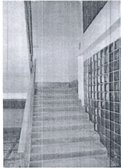
Фото №11 – Лестница внутри здания
