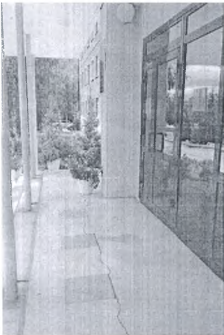
Фото №7 - Входная площадка перед дверью
